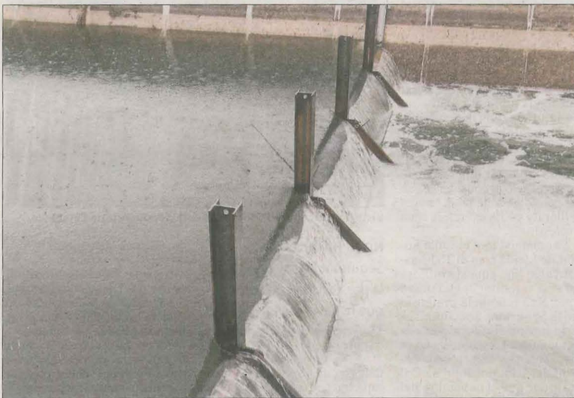
Tancaments al Canal Principal d'Urgell per assegurar el proveïment d'aigua de boca.
