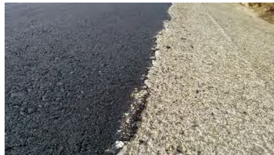
Detall de la trobada del nou paviment d'aglomerat en calent amb la cuneta de formigó
