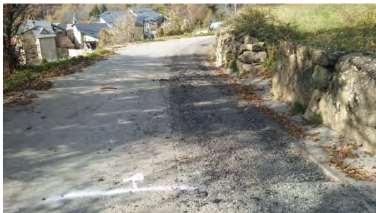
Detall del fresat d'una franja de 50 cm al marge de la cuneta de formigó existent
